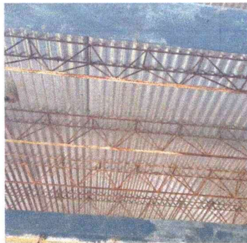
Foto 3: Mantenimiento de estructura de techo de metal.
