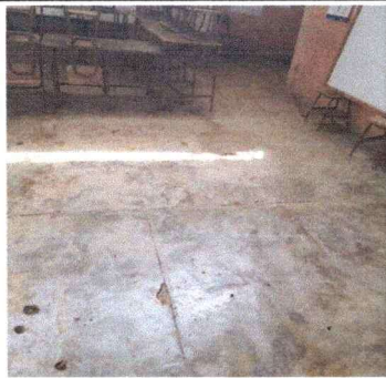
Foto 5: Sustitucion de torta de piso por piso ceramico.
